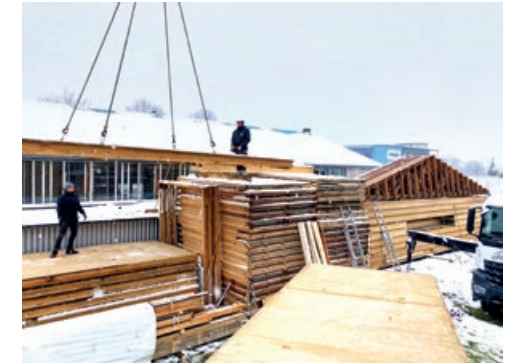
Déchargement des éléments de structure ©atelier bleu
