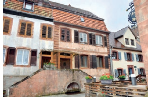
Façade avant les travaux ©Rose Schreiber
