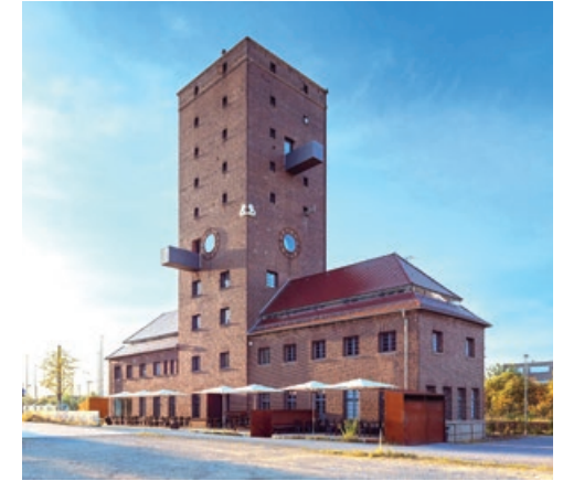
Tankturm — Außenansicht ©Thilo Ross
