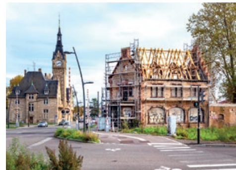
L'entrée du quartier Coop – la capitainerie (à gauche) et la maison Schutzenberger (à droite) © Pierre Frigeni
