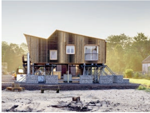
Gebäudeprototyp RoofKIT © Zoëy Braun
