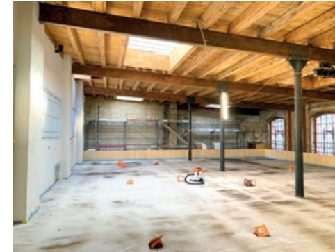
Umnutzung Tramdepot – Umbau Eicher Architekten © Esther Baur
