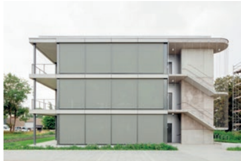
Bürogebäude TINA, Architekten - Studio Sozia © Kim Fohmann
