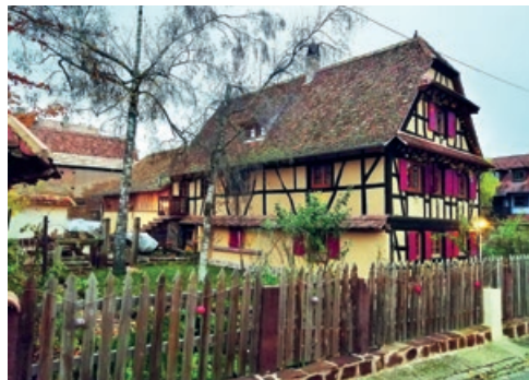
Façade après les travaux ©Loïc Cavalier
