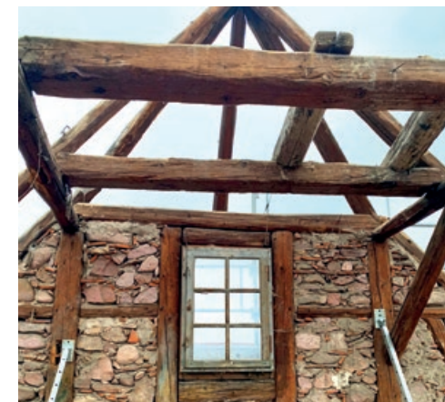
Travaux en cours en mars 2023 © Christophe Hurst
