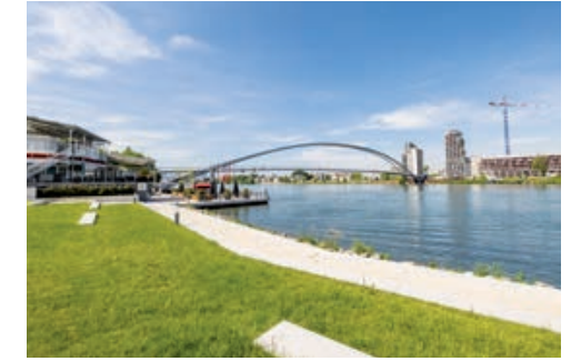
Umgestaltung des Rheinparks in Weil am Rhein – Eindruck der unternommenen Arbeiten ©Marie-Soehnen
