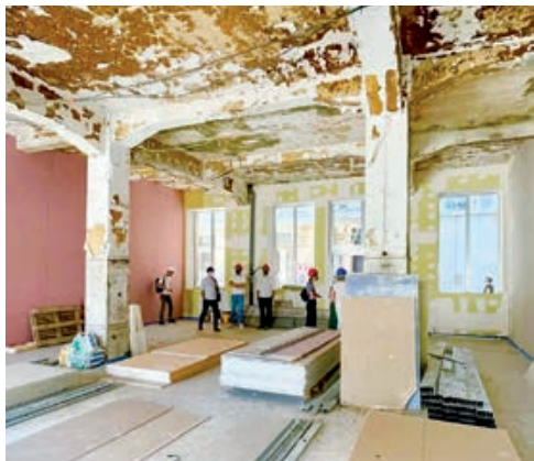
Kaleidoscoop, chantier de réhabilitation ©Kaleidoscoop
