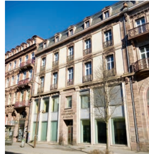
Façade de l'ancienne Chambre des comptes de Strasbourg ©BOMA - Les BONnes MATières
