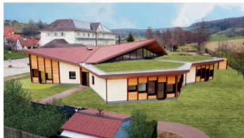
Périscolaire à Lembach ©Ateliers D-Form, Matthieu Husser Architectures
