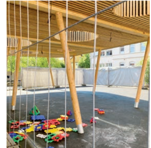
Préau de l'école de Brunstatt ©Esquisse architecture
