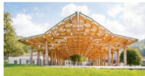
Halle et périscolaire de Tendon ©HAHA
