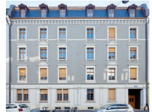
Strassenfassade der Hochstrasse ©Michael Fritschi
