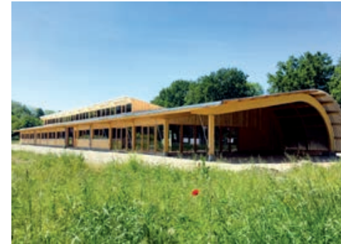
Entrepôt en matériaux biosourcés pour un maraîcher bio à Colmar ©architectes Goetschy + Cabello
