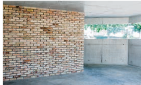
Garagenwand mit Mauerwerk aus alten und neuen Ziegeln, Wohnhaus, © Sennrich & Schneider Architekten GmbH
