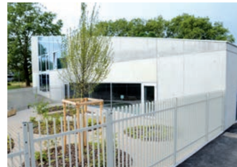
Centre socioculturel du Port du Rhin – Ballast architectes, 2017 ©J-M Bernardt – EMS
