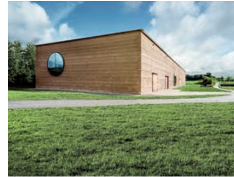
Maison des plantes Ricola, Laufen, Suisse, 2014, Herzog & de Meuron. Façade en pisé réalisée en collaboration avec Martin Rauch © Markus Bühler
